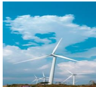
Gambar 1. Pembangkit Listrik Tenaga Bayu
